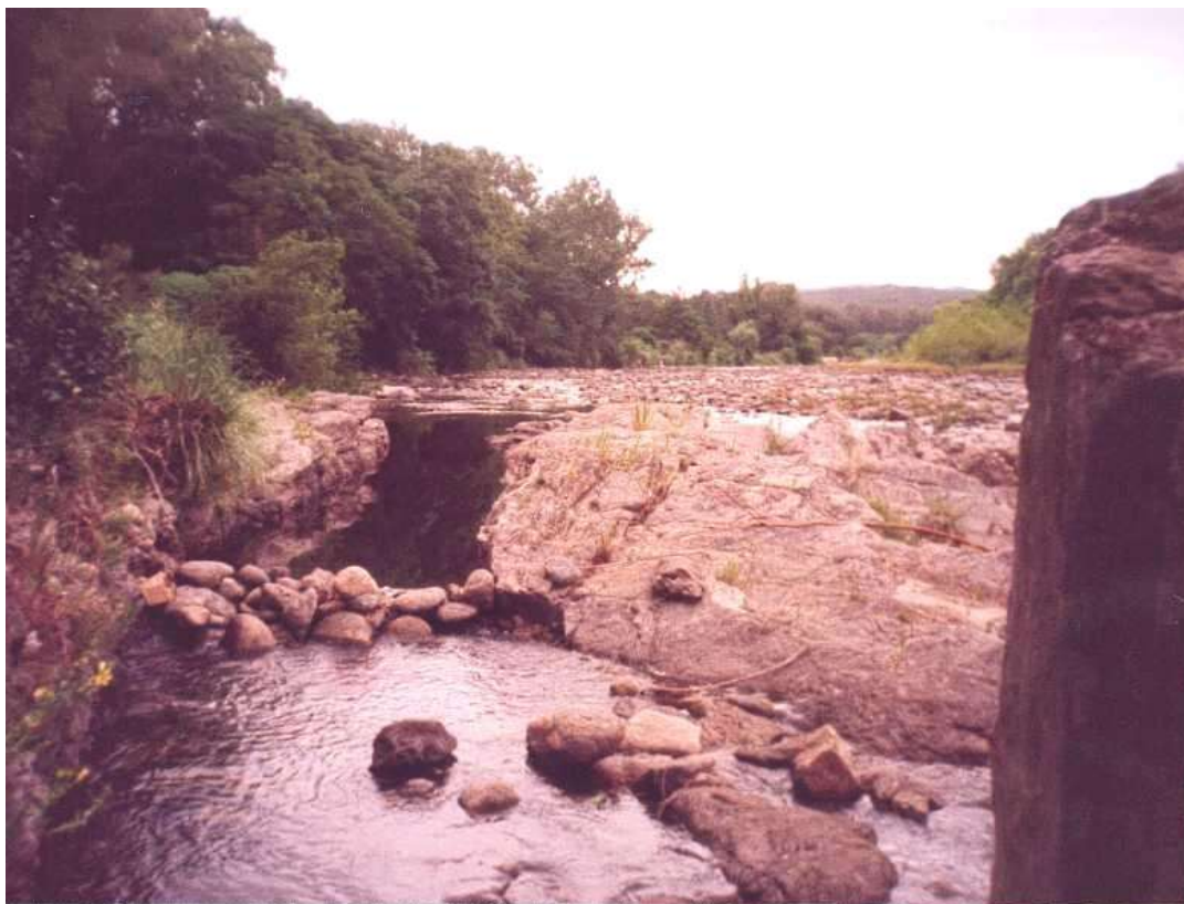
Foto 1 del Informe: Toma de agua excavada en la roca. URIBE, Alfonso (2004) 2
