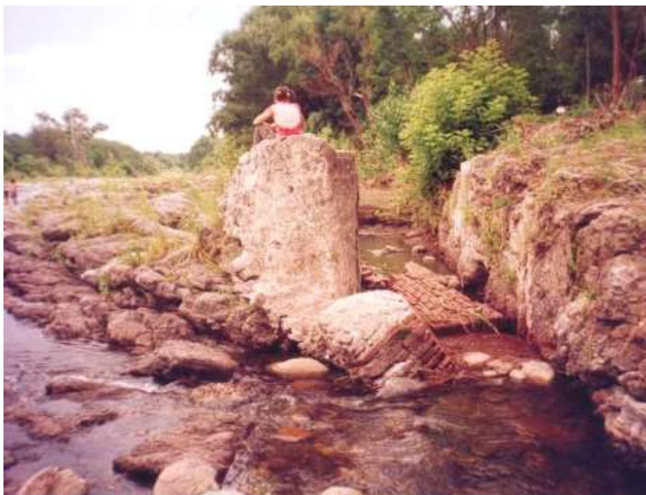
Foto 2 del Informe: Pared de piedra y cal hidráulica. URIBE, Alfonso (2004) 3
