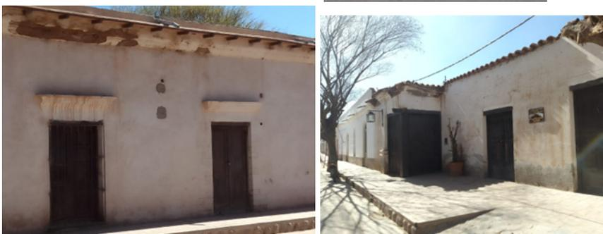
F N°6y 7.- muros con intervenciones, Arreglos y emparches con mortero de arena, cal y cemento.
