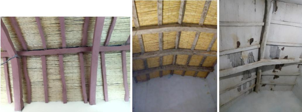
.a;b;c.- estructuras portantes del techo con tirantes de madera arqueados sobre los cuales se colocaron un tirante o viga cumbrera donde apoyan las vigas secundarias o varas, marcando las dos aguas.
