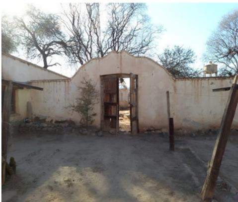
*Foto N°1.-.-Tapia de fines de S.XIX, del segundo patio, base de piedra y pared de adobe de 44x20, rematada con hilera de tejas, en arcada que acompaña la abertura, puerta de madera de dos hojas con dintel recto.*
