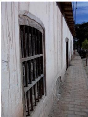
Foto N°8.- En esta fotografía se puede observar la desviación hacia la izquierda de la línea de construcción, los muros que se conservan están relativamente aplomados en su mayoría.
