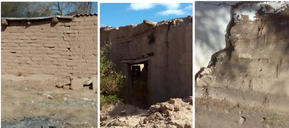
F N° 4 y 5.- molduras y saledizo Muro con revoque de cal y arena, con varias capas de pintura a la cal.
