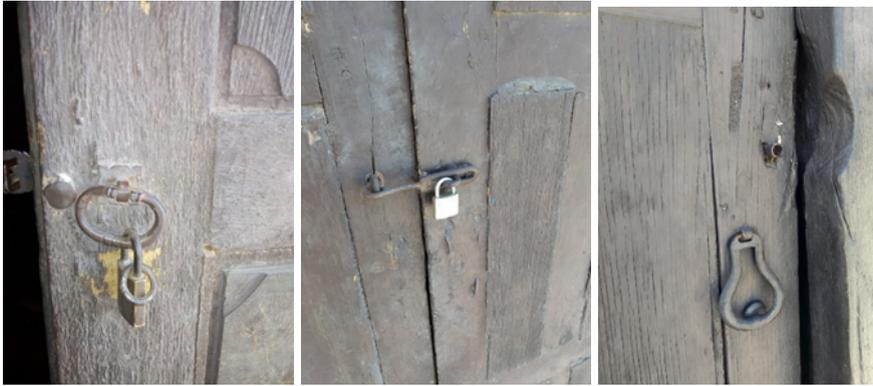
*Foto N°56.-con tirador de forja, Foto N°57.- Con aldaba simple en hierro, Foto N°58.- Llamador de hierro y bocallave*
