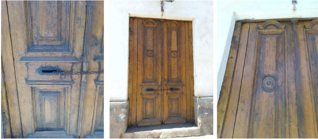
*Foto N°24;25;26.- Puertas esquinera colonial "Las puertas esquineras tienen dinteles rectos, las esquinas tienen una jamba de madera dura y sobre ella se cruzan los dinteles rematados con ménsulas cruzadas, sosteniendo así el peso de las esquinas."*
