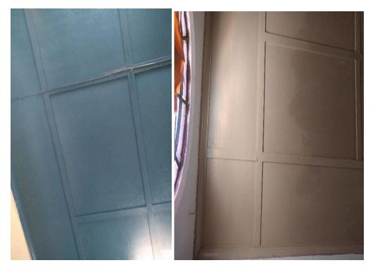
El cielorraso es de planchas de cartón colocadas sobre un bastidor de madera y cornisa que enmarcan el rectángulo. El techo de la casa y de toda la construcción, es de vigas maderas y chapas de zinc.
