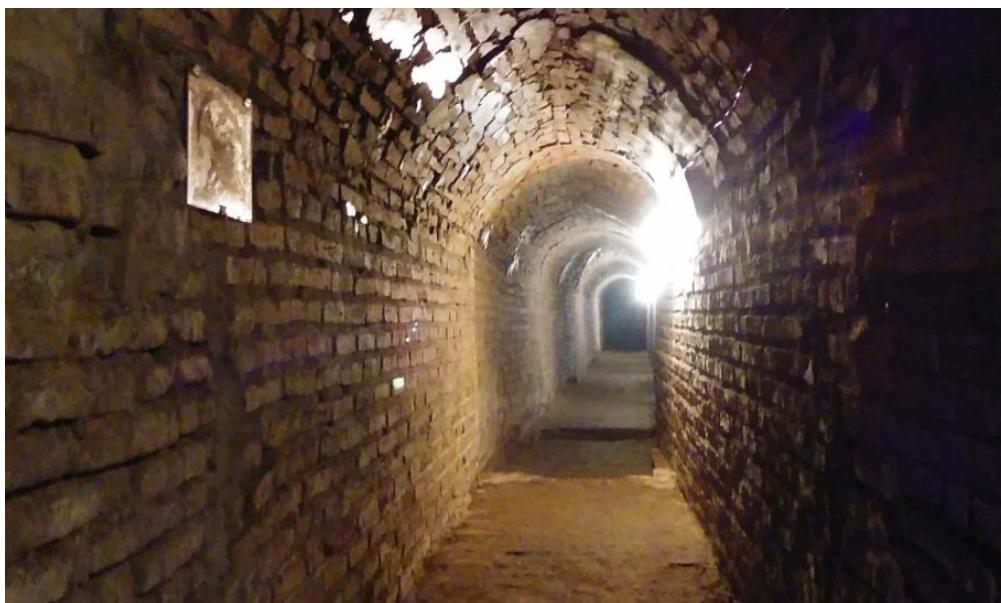
Figura 61 Fragmento de túneles correspondientes al ducto de venteo de la chimenea de “La Estrella” 61
