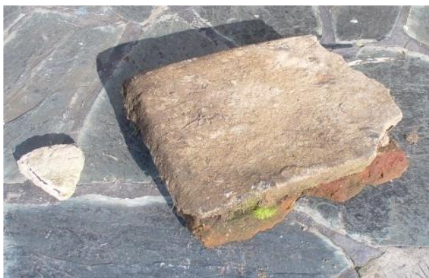
Figura 58 Revoque de los ladrillos 58
