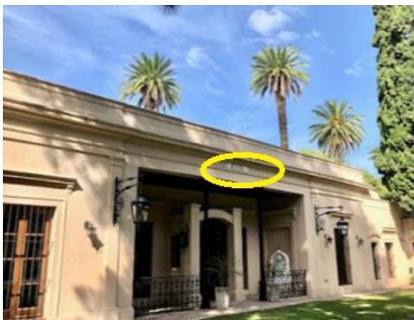
Figura 10 Edificio principal de la Hostería El Cazador 10
