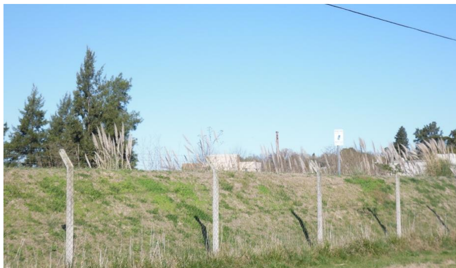
Figura 23 Fotografía que muestra terraplén del Barrio El Cazal para cumplimentar cota de 4msnm 23
