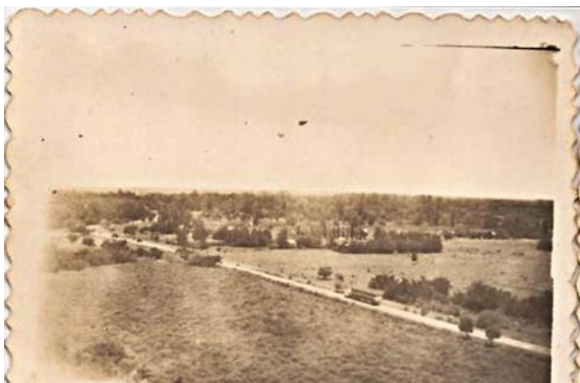
Figura 27 Vista desde el tope de la chimenea 27
