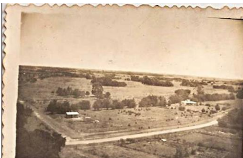
Figura 26 Vista desde el tope la chimenea 26
