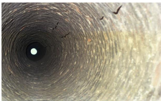
Figura 48 Interior del fuste o tubo 48
